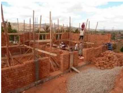
Chantier de la construction en 2010
